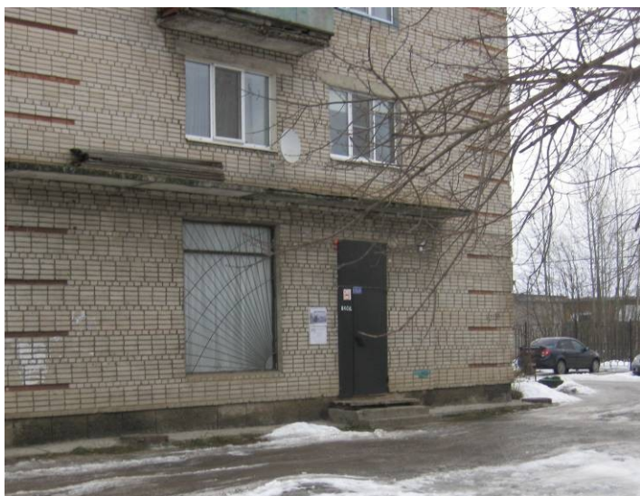
Фото №7. Входная площадка, территория прилегающая к зданию
