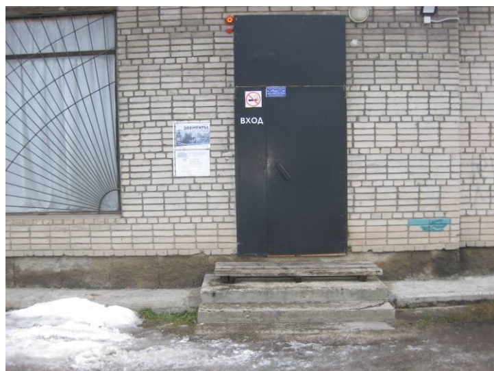
Фото №6. Лестница наружная
