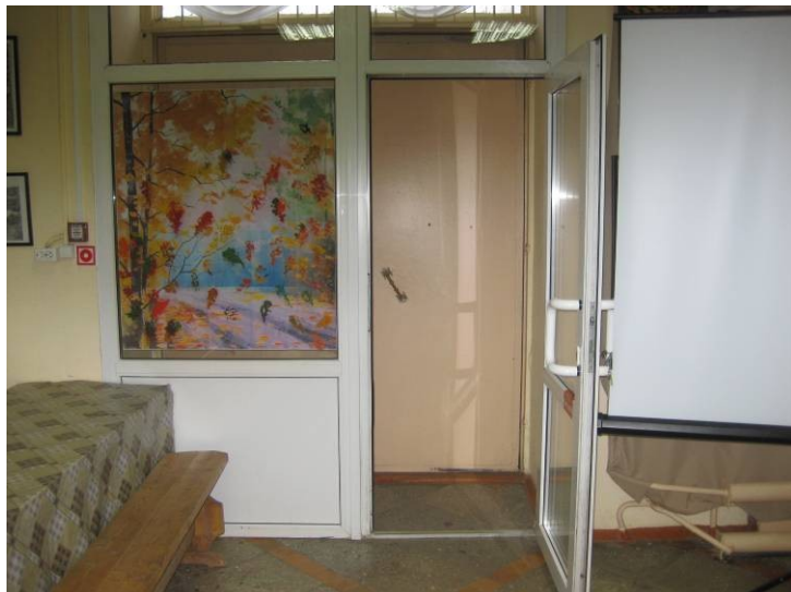
Фото №14. Пути движения (эвакуации) в здании
