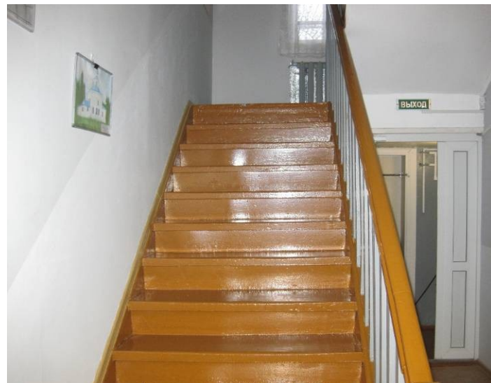
Фото №8. Лестница на второй этаж
