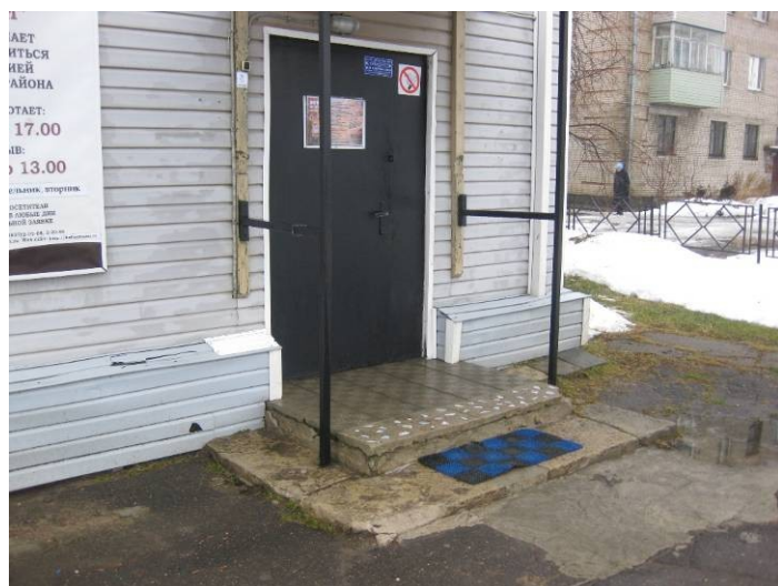
Фото №4. Входная площадка
