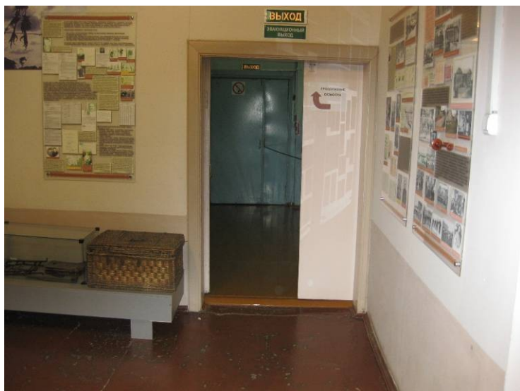
Фото №13. Пути движения (эвакуации) внутри здания
