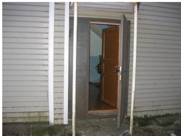
Фото №14. Эвакуационный выход
