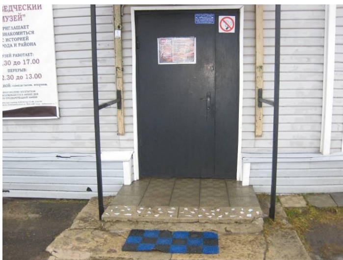
Фото №5. Входная дверь
